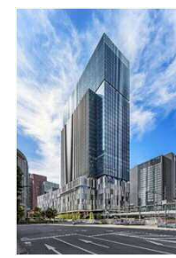
JPタワー大阪 (2024年3月竣工)
